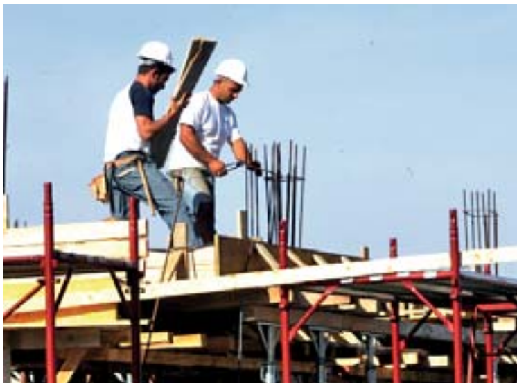
Un cantiere edile
